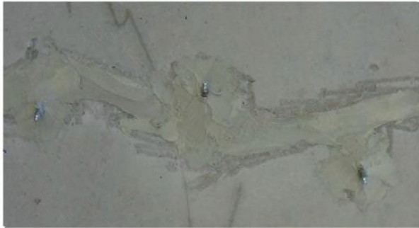
Figura 1. Packere forante fixate in jurul fisurii si sigilate cu adeziv epoxidic potrivit, din gama MasterBrace .
